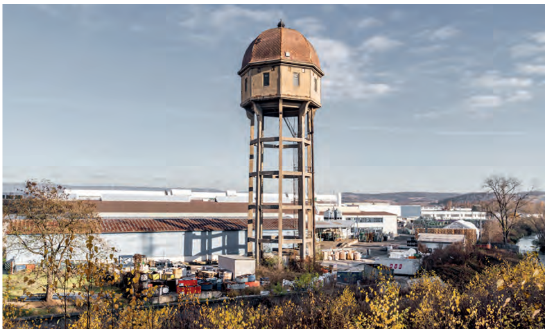
Věžový vodojem v areálu skláren v Chudeřicích u Bíliny (autor: Jiří Dvořák)
