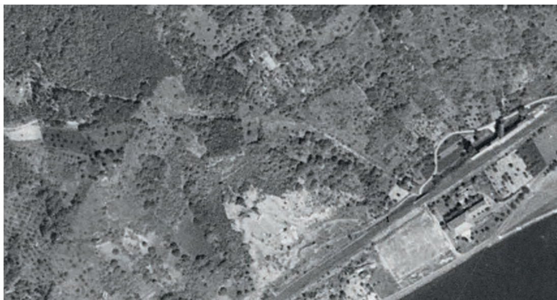
Na leteckém snímku z roku 1946 je patrný průsek po instalaci potrubí mezi čerpací stanicí a přelivnou věží na Dubickém kopci (zdroj: ČÚZK | CC-BY 4.0, Historická ortofotomapa; CENIA 2010 a GEODIS BRNO, spol. s r.o. 2010; Podkladové letecké snímky poskytl VGHMÚř Dobruška, MO ČR 2009)
